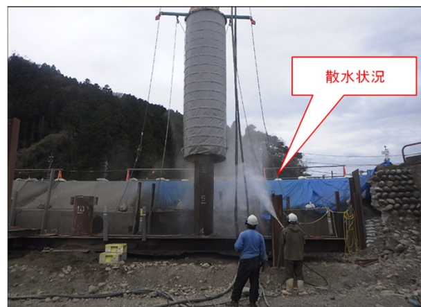
写真-1 防塵カバーの設置及び散水状況
