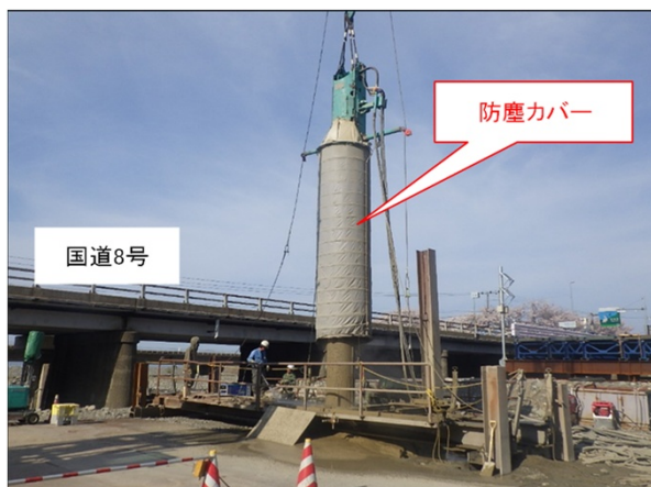
写真-1 防塵カバーの設置及び散水状況
