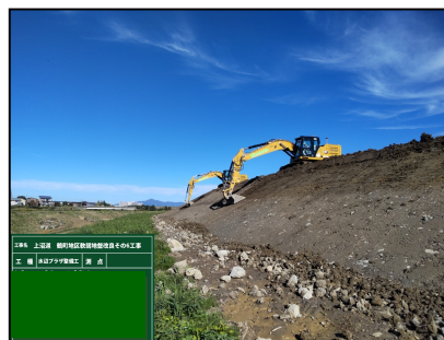
写真-3 ICT建機による施工
