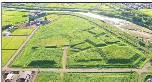
写真-1 着手前現況写真
