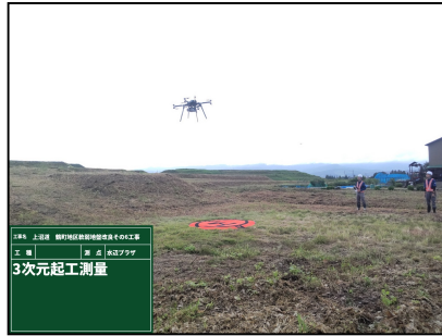
写真-2 現況地形測量
