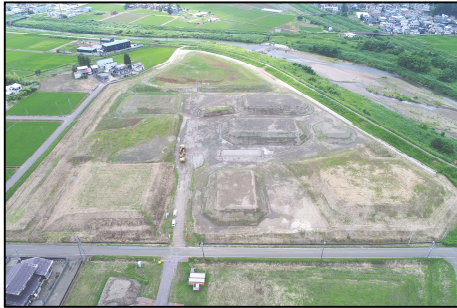
写真-4 整備完了写真
