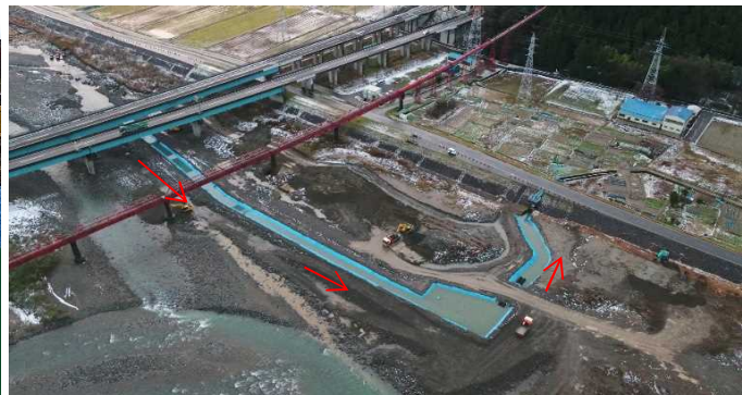
(写真-2 仮水路設置完了)
