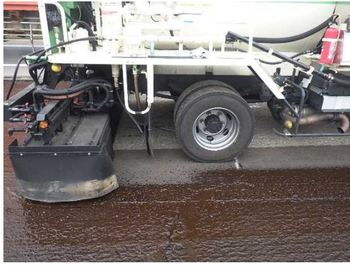
専用ディストリビュータによる乳剤散布状況
