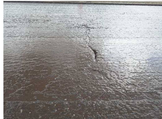
ハイブローンSA散布後のクラック充填状況
