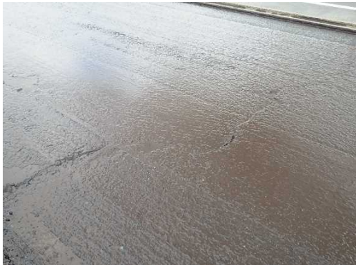
ハイブローンSA散布後のクラック充填状況
