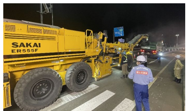
写真 2 路面切削施工状況
