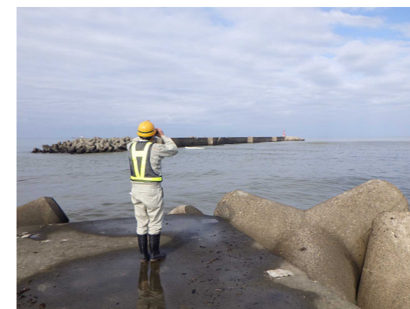
関川 2次点検 状況写真 (沖側導流堤)
