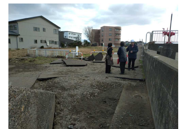
関川 職員点検及び周辺住民 聞き取り状況写真 (港町第2排水樋管付近)
