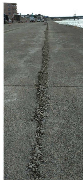
1月6日応急復旧完了
