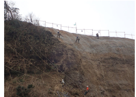
法面上部の金網設置作業【1/18(木)10時撮影】
