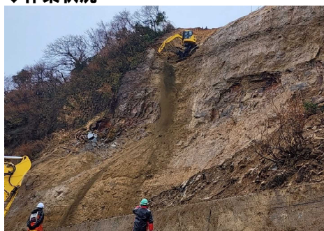
ロッククライミングマシンでの作業【1/12(金)11時撮影】
