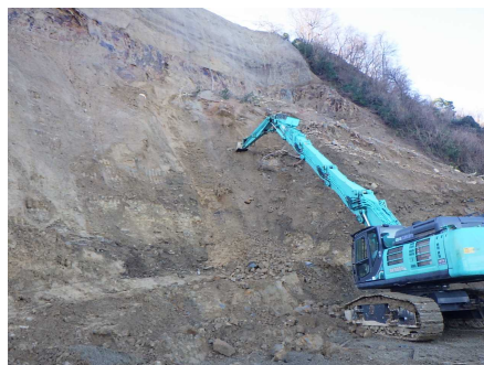
ビル解体用の大型重機による法面中間部の崩落土撤去作業【1/17(水)10時撮影】
