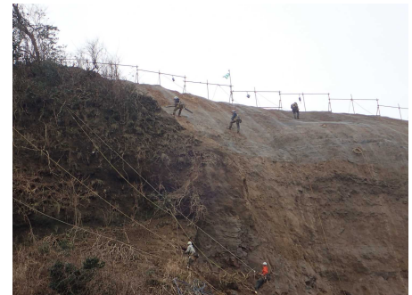
法面上部の金網設置作業【1/18(木)10時撮影】
