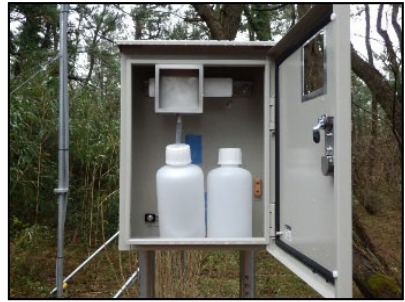
土研式タンク法設置状況
