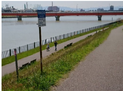
(事例) 関屋分水路 散策等利用状況
