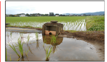
田んぼダム排水口の例（排水口にゲートを設置）
