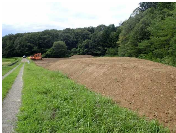
県営ほ場整備事業での活用 (上越市吉川区原之町)
