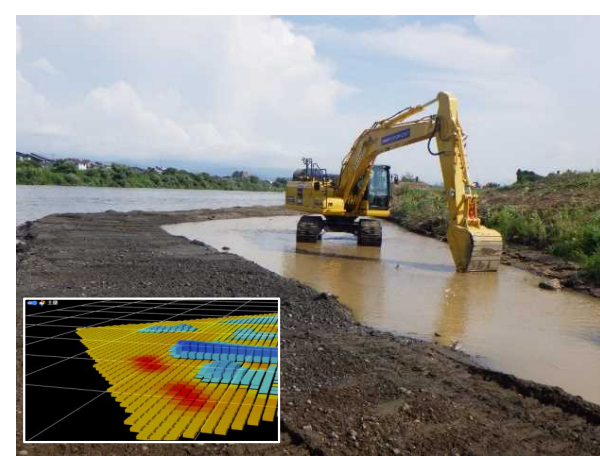
ICTを活用した河道掘削
