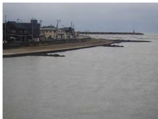
袋詰め玉石 設置後全景
