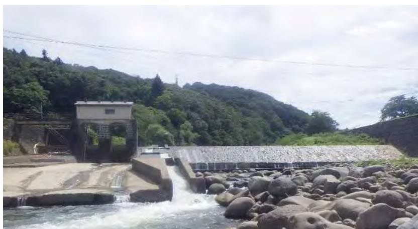
板倉発電所取水堰堤
