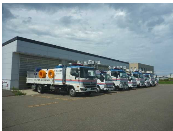
藤巻災害対策車格納庫
