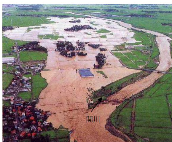
堤防決壊状況（妙高市月岡地先）
