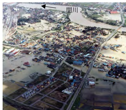
昭和 57 年 (1982 年) 9 月洪水 上空より関川大橋を望む
