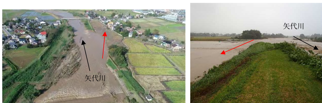
関川上流指定区間堤防決壊箇所（矢代川） （令和元年（2019年）10月）
