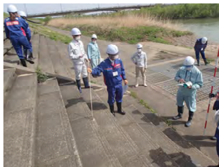
親水施設等の点検状況
