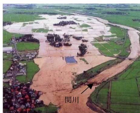
平成 7 年 (1997 年) 7 月洪水 妙高市月岡地先破堤状況 (旧新井市)
