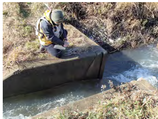
高水敷魚道での目視調査
