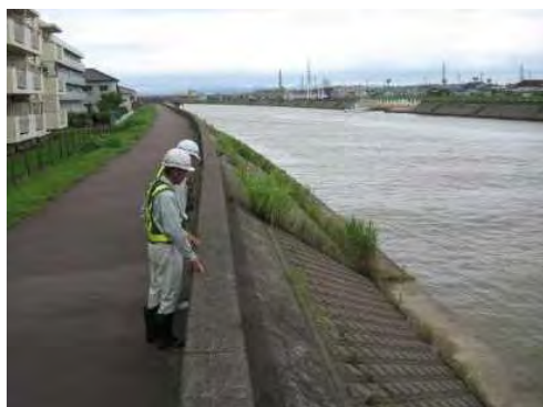
中越沖地震後の巡視状況 (平成 19 年 (2007 年) 7 月)
