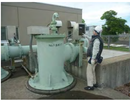
排水機場の定期点検
