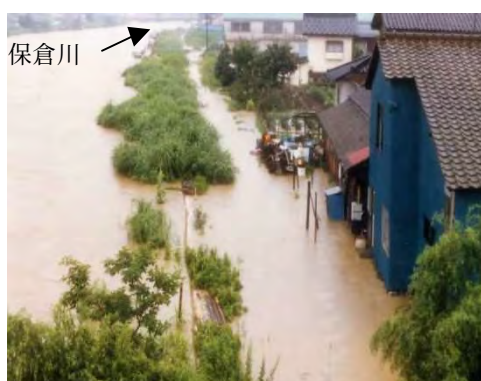
昭和 60 年 (1985 年) 7 月洪水 保倉川右岸溢水状況
