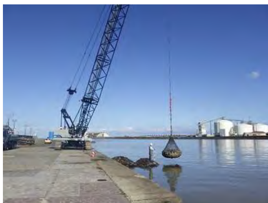
袋詰め玉石 設置状況
