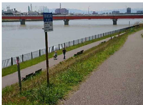
(事例)関屋分水路 散策等利用状況
