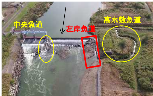
【魚道の整備、改修経緯】
