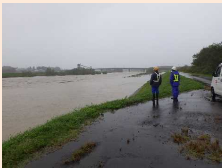
洪水時巡視の状況
