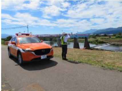
河川巡視状況
