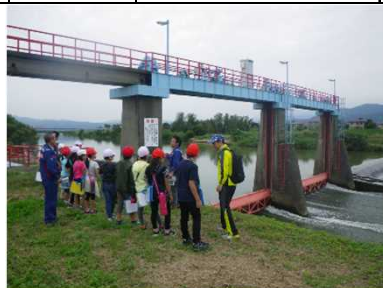
近隣の幼稚園に利用される堤防天端
