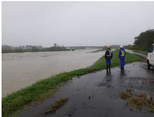
洪水時巡視の状況
