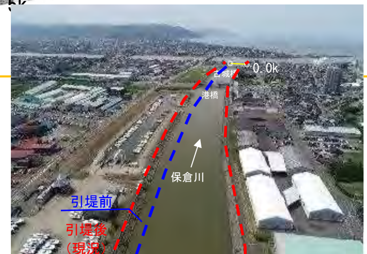
保倉川現況写真
