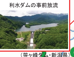
利水ダムの事前放流 (笹ヶ峰ダム・新潟県)
