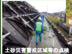
土砂災害警戒区域等の点検
