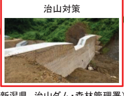
治山対策 (新潟県、治山ダム・森林管理署)
