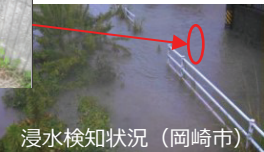
浸水検知状況（岡崎市）
