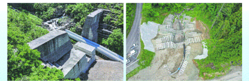
根知川砂防堰堤工
