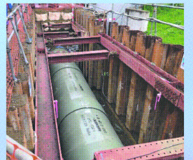
直径2mの暗渠管を地中に埋設する雨水幹線整備の様子
