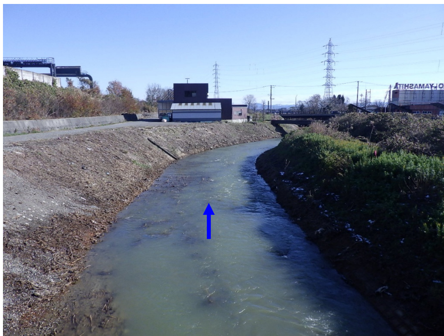
一級河川 正善寺川 (河床掘削)
