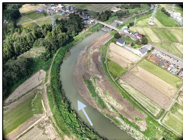
河床掘削（浦川原区飯室）
