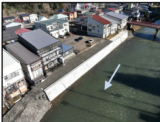
河川整備（浦川原区有島）
