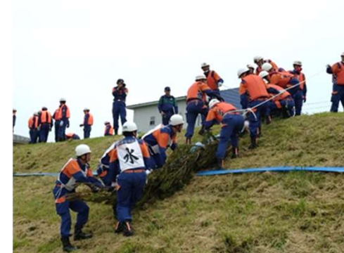
●木流し工－堤防法面への設置
