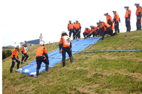
●シート張り工－堤防法面への設置
