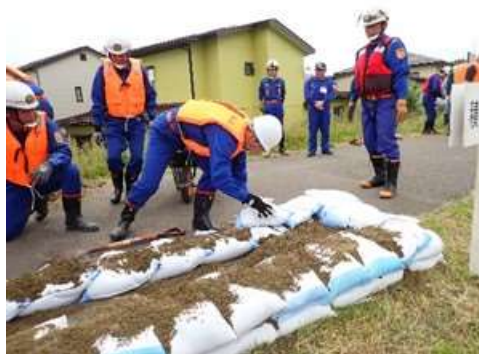
●積み土のう工－土のう積み作業
