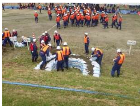
●月の輪工－土のう据付・土砂充填
