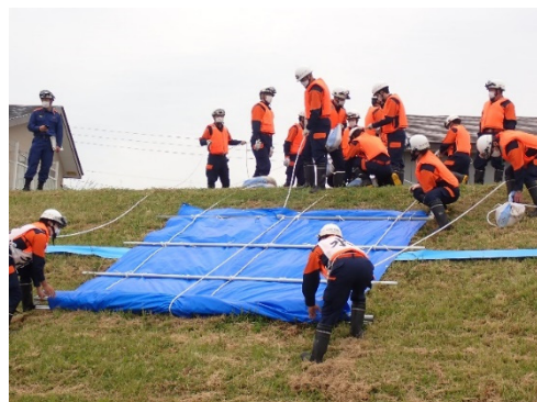
●シート張り工－堤防法面への設置
