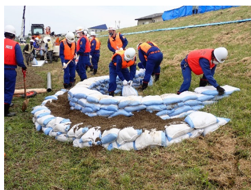
●月の輪工－土のう据付・土砂充填
