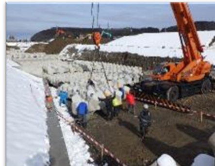
根固めブロック据付状況
