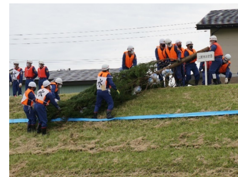
●木流し工－堤防法面への設置
