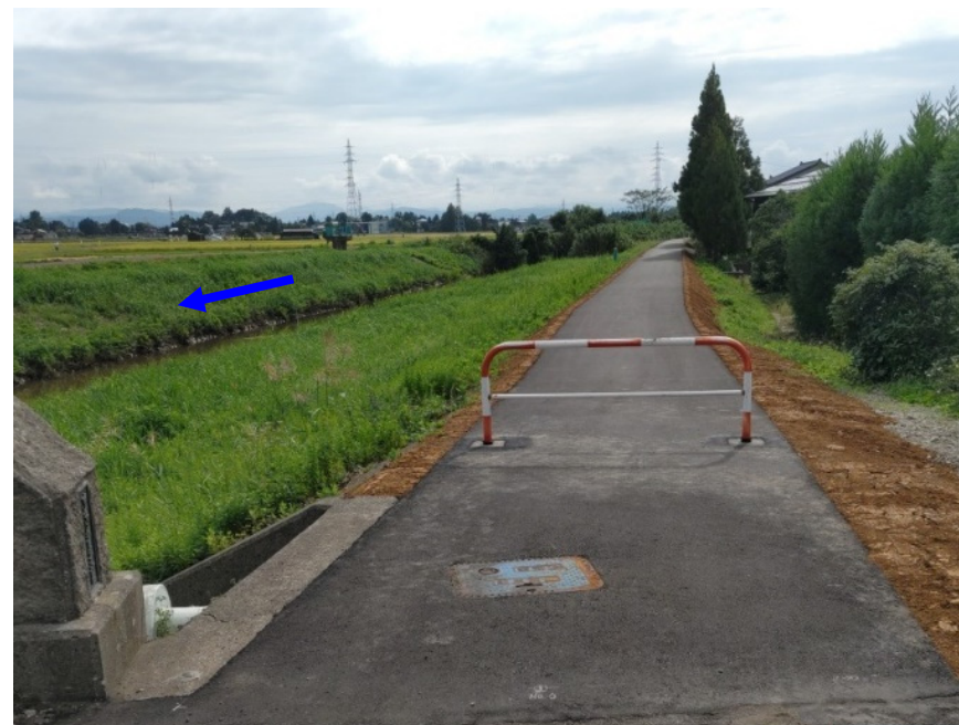
一級河川 戸野目川（堤防天端舗装）
