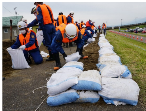
●積み土のう工－土のう積み作業
