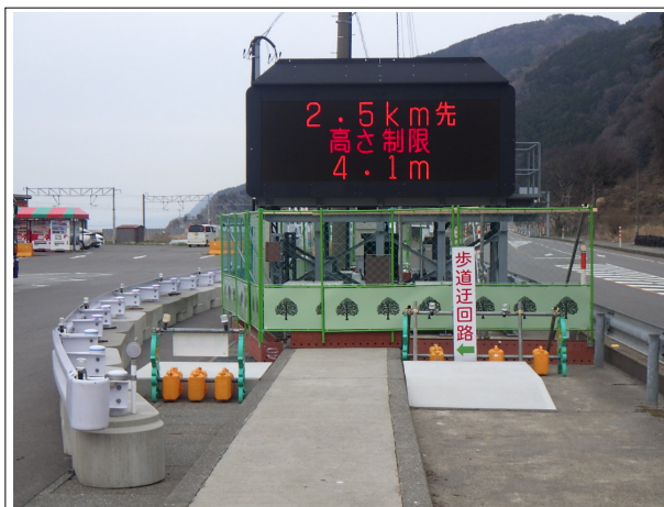
【写真-3 仮設歩道迂回路完成】
