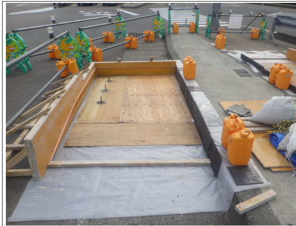
【写真-1 コンクリートスロープ打設前】
