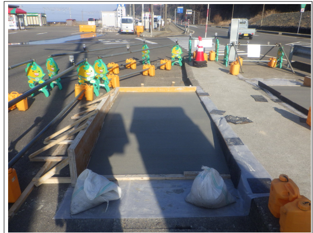
【写真-2 コンクリートスロープ打設後】
