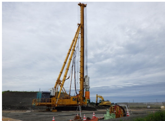
写真-2 施工状況
