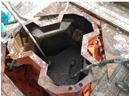
写真-7 締固め状況
