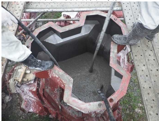
写真-7 締固め状況
