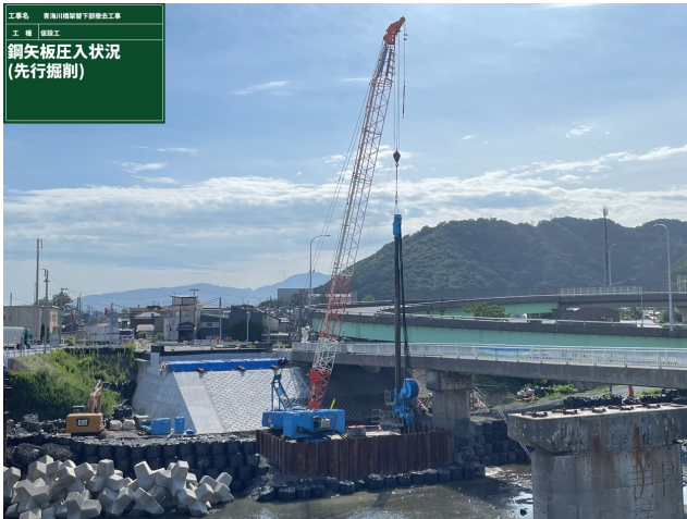
写真-3 施工状況
