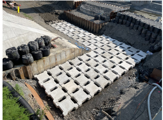
写真-8 根固ブロック据付完了
