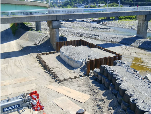
写真-7 鋼矢板施工完了
