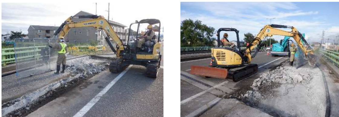
写真-2 既設間詰めコンクリート取壊し状況
