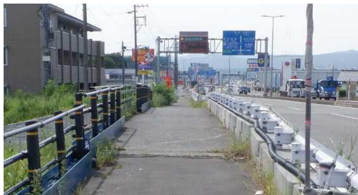
写真-1 既設歩道部の取壊し前状況
