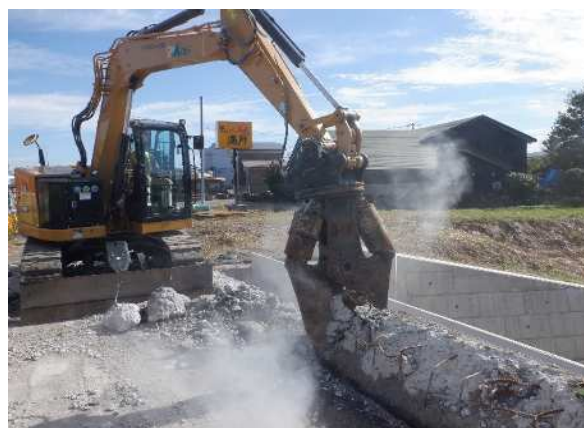
写真-3 既設地覆取壊し状況
