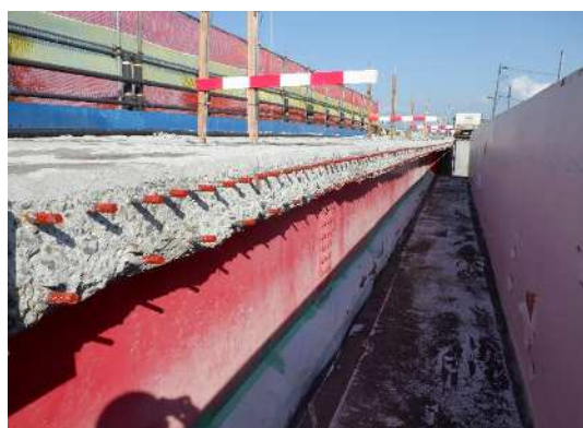
写真-6 斫り作業完了
