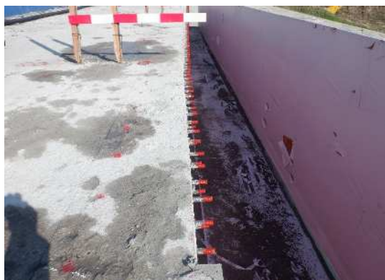
写真-6 斫り作業完了
