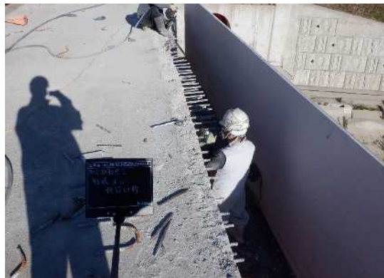
写真-5 鉄筋切断状況
