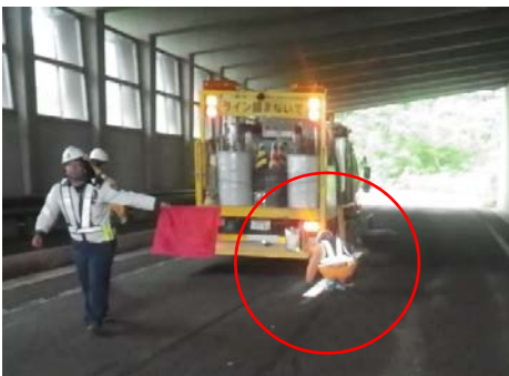
写真-2 作業中の幅確認
