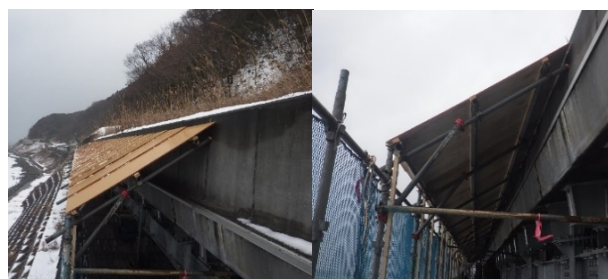
写真-10 施工区間の屋根養生
