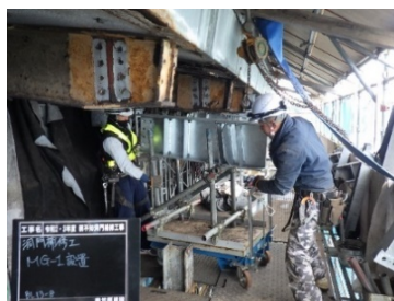
写真-4 新鋼材設置
