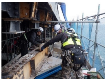
写真-3 撤去材運搬
