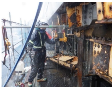
写真-8 養生前作業環境
