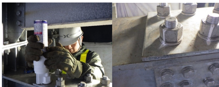
写真-7 線引き屋によるマーキング
