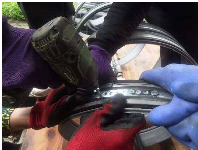
写真 - 9 ビス止め状況
