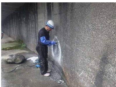
写真 - 1 4 管口シール切削
