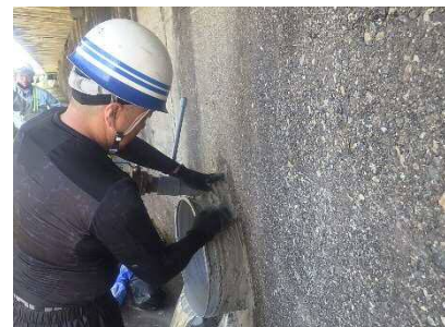
写真 - 11 注入口取付状況
