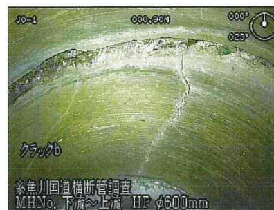
写真 - 2 テレビカメラ調査写真 下流より0.9m クラック幅42mm
