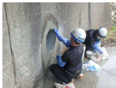
写真 - 1 5 モルタル仕上げ
