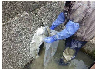
写真 - 1 3 溢流確認
