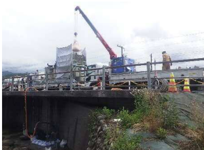
写真 - 1 2 間詰め材注入
