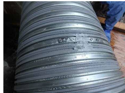
写真 - 10 プロファイル接続完了
