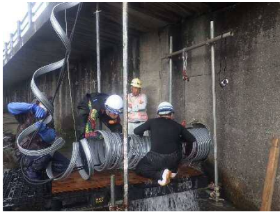
写真 - 7 製管状況
