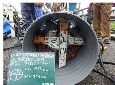
写真 - 6 巻き出しリング作成
