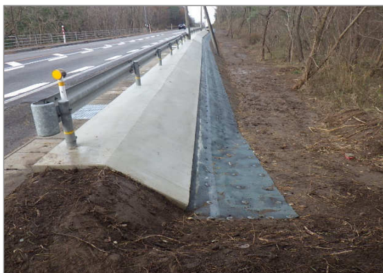
写真-6 完成 路肩損傷箇所復旧
