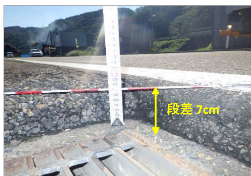
写真-1 車道舗装面より街渠樹天端が7cm低く、段差が生じている
