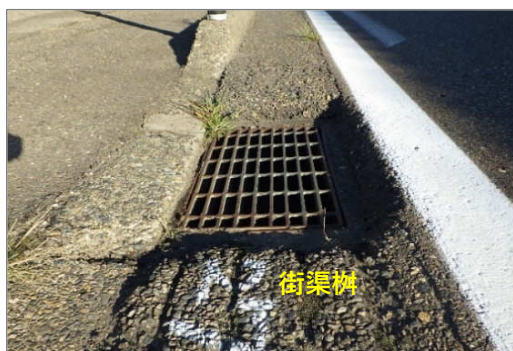
写真-1 車道舗装面より街渠樹天端が7cm低く、段差が生じている
