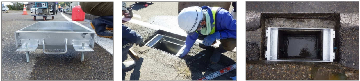
写真-3 かんたんグレーチング設置
