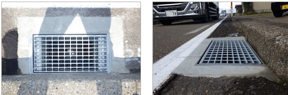
写真-5 完成 車道との段差を解消
