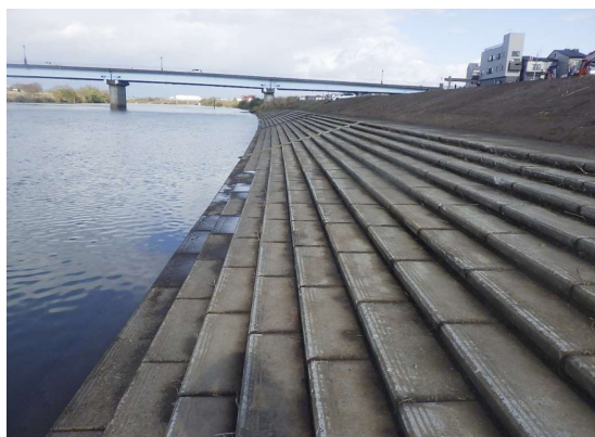
写真-1（稲田橋右岸上流）
