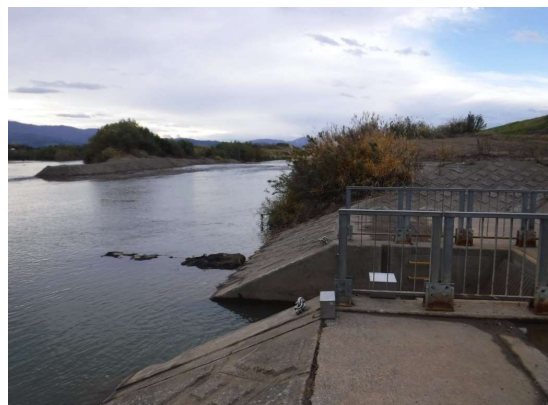
写真-2（上越消流雪用水取水口）
