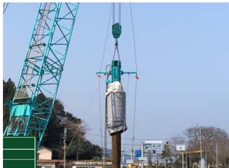
写真5 鋼管杭状況(粉塵の発生なし)
