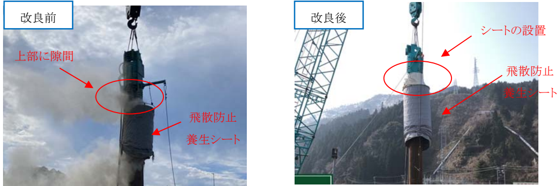
写真3 飛散防止養生シートの改良前後
