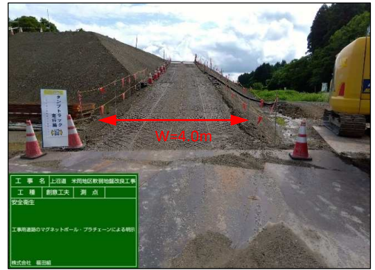
写真-6. 工事用坂路
