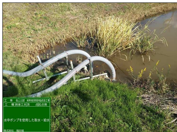
写真-11. ため池の給水箇所
