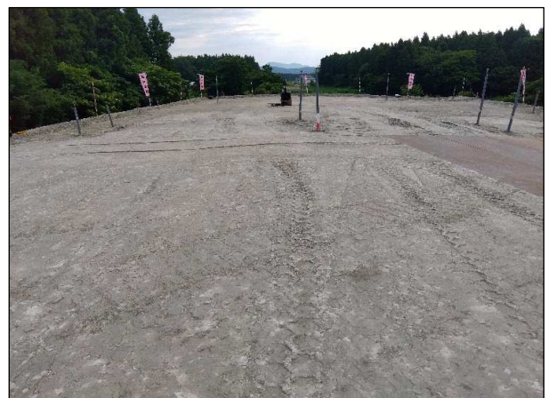
写真-5. 路体盛土法肩明示
