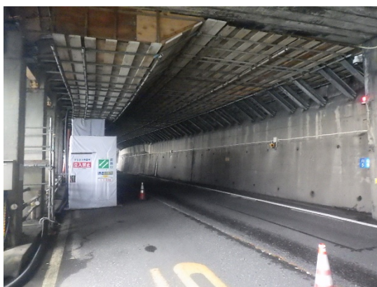
写真 - 1 向山5号洞門足場全景
