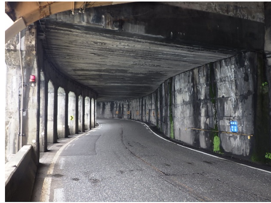
写真 - 4 洞門内の急カーブ
