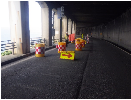
写真 - 7 交通誘導員による片側交互通行規制
