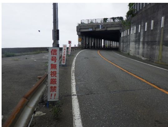
写真 - 1 3 規制看板の追加
