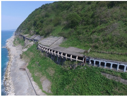
写真 - 3 向山洞門全景
