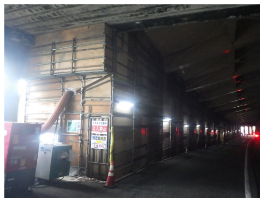
写真 - 2 向山7号洞門足場全景
