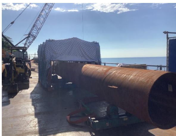
写-4 横継現場溶接養生枠設置状況
