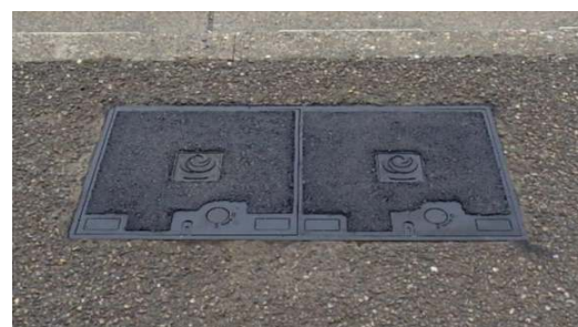
電線共同溝マンホール鉄蓋更新完了
