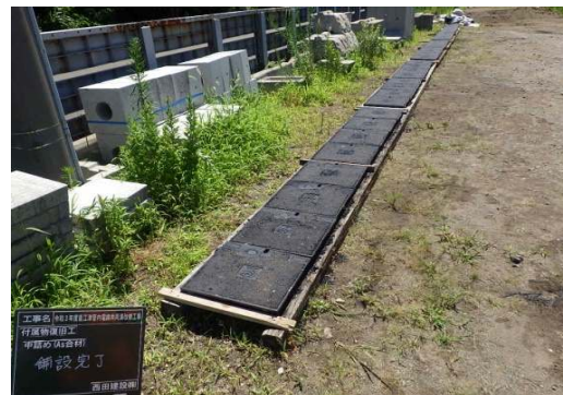
写真-4 化粧蓋舗設(充填)完了
