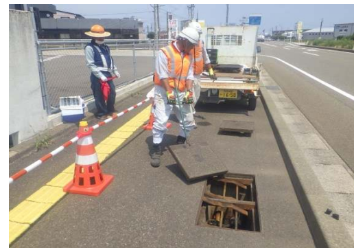
写真-5 既設化粧蓋の入替え状況
