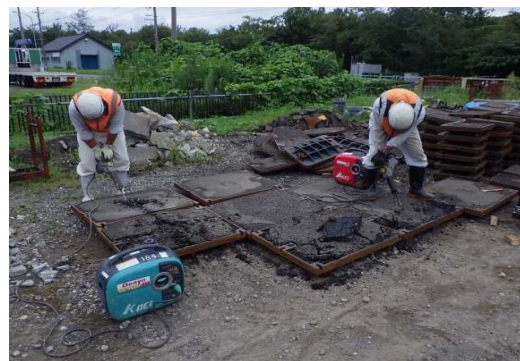
写真-6 既設化粧蓋充填材取壊し状況
