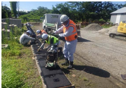
写真-3 化粧蓋舗設(充填)状況
