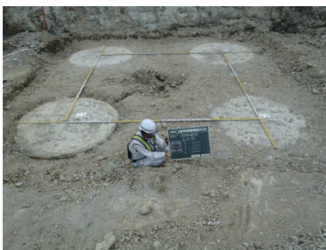
写真-8 従来の出来形測定状況
