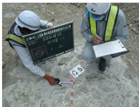
写真-9 従来の出来形測定状況
