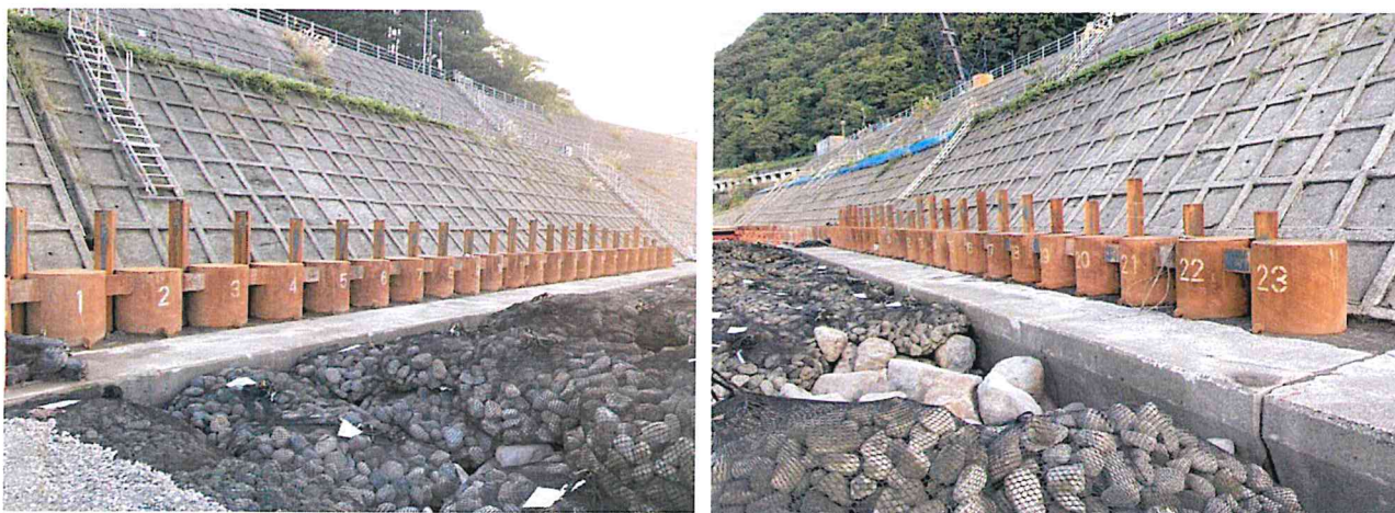
写真-5 施工完了全景
