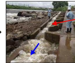
隔壁の一部を撤去し、幅80cmの階段式魚道に改修
