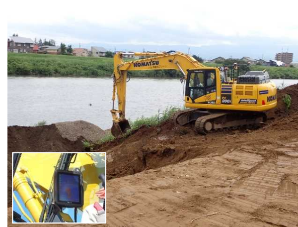
ICTを活用した河道掘削
