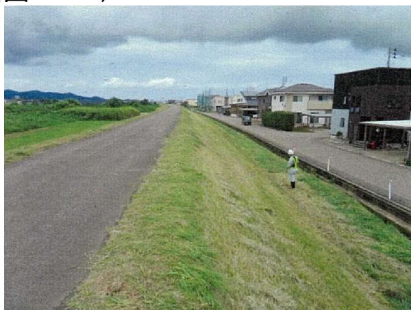
川裏法面点検状況
