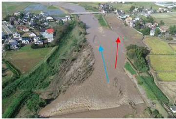
関川上流指定区間堤防決壊箇所 (矢代川) 令和元年10月13日午前6時30分 (出典: 新潟県)
