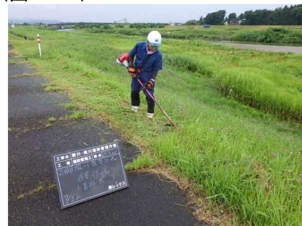
除草作業の状況
