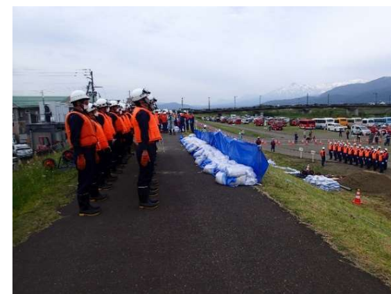
積土のう工ー設置完了状況
