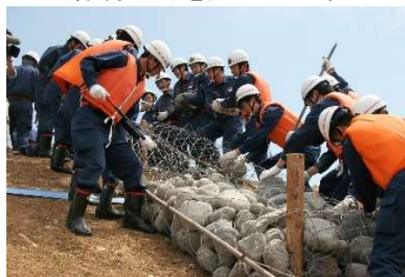
H18関川姫川連合水防演習状況 [平成18年5月27日]
