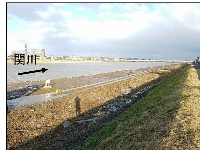
樹木伐採後の状況
