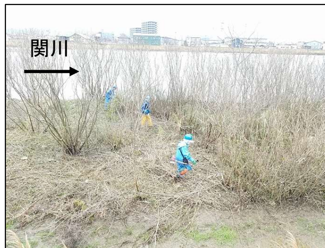
樹木伐採作業の様子
