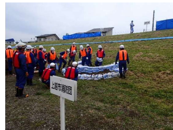
月の輪工ー土のう据付
