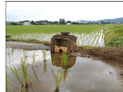
田んぼダム排水口の例 （排水口にゲートを設置）
