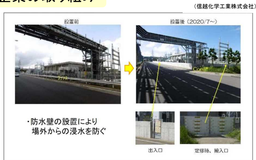
防水壁の設置
