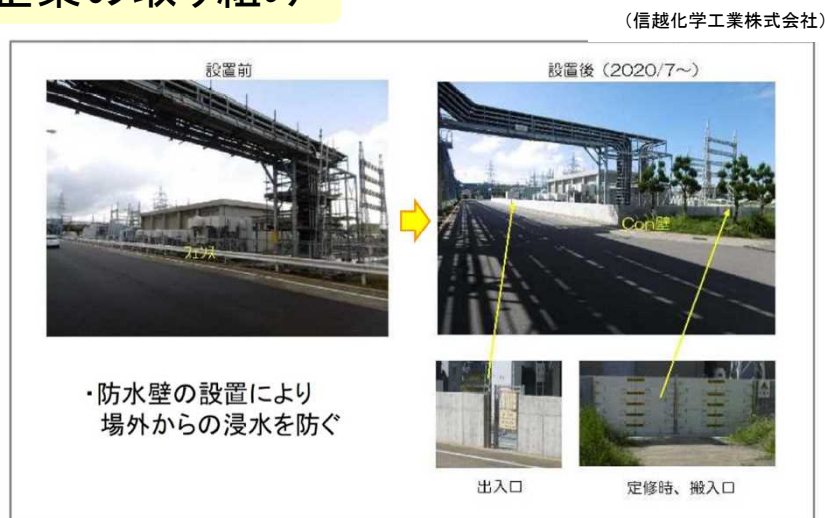
防水壁の設置
