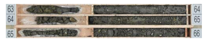
図3 Pg1層(礫質土)のボーリングコア
