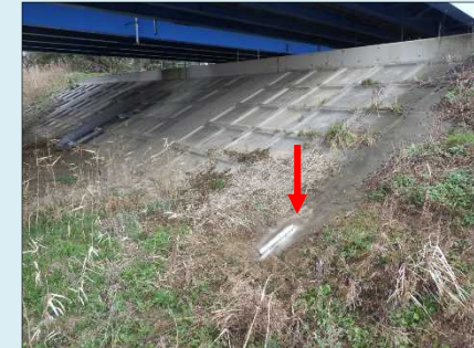
保倉川 北陸自動車道右岸観測所
