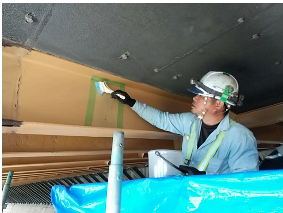
写真-6 剥離剤使用の塗装剥がし
