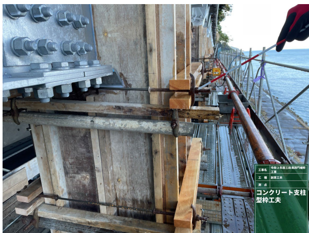
写真-6 型枠の工夫、コンクリート支柱出来映え
