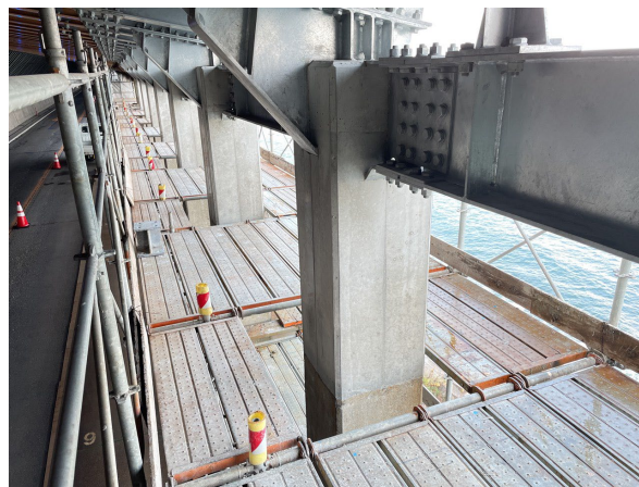
写真-6 型枠の工夫、コンクリート支柱出来映え
