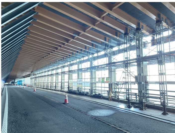
一区間の鋼材取替完了
