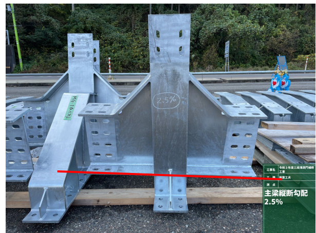
写真-3 主梁の水平と2.5%勾配部材
