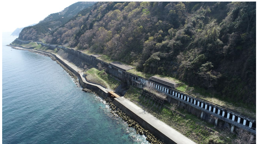
写真-2 現場全景
