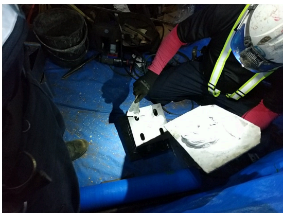
写真-4 パテ材塗布による不陸整正
