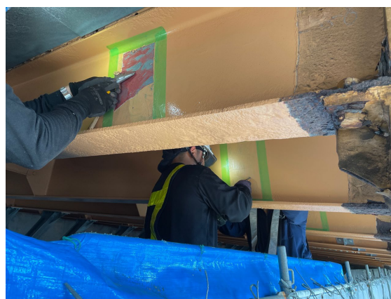
写真-6 剥離剤使用の塗装剥がし
