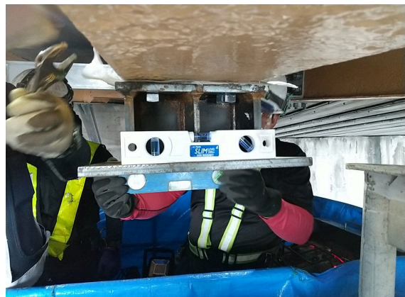
写真-4 パテ材塗布による不陸整正
