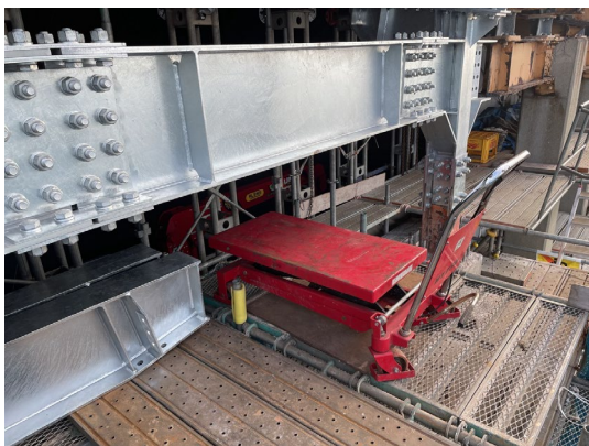
写真-5 台車使用による鋼材取付
