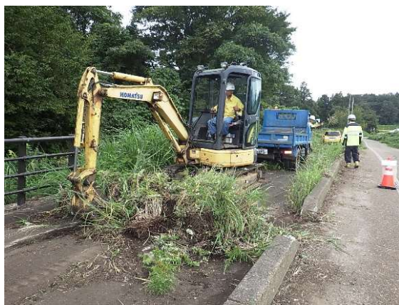
バックホウ・ダンプトラックによる集積・積込・運搬
