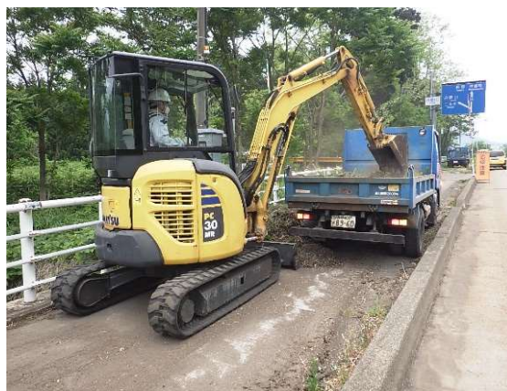
バックホウ・ダンプトラックによる集積・積込・運搬
