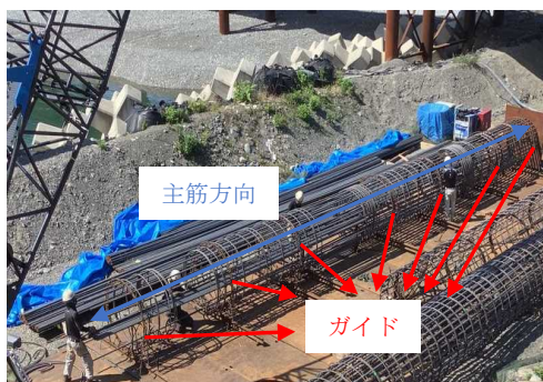
写真-13 鉄筋籠製作
