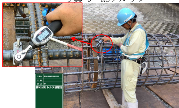
写真-10 トルクレンチ締付け数値確認
