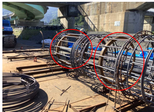
写真-7 補強リング取付
