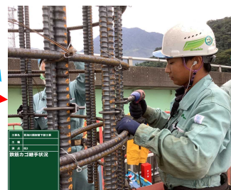
写真-4 鉄筋籠継手
