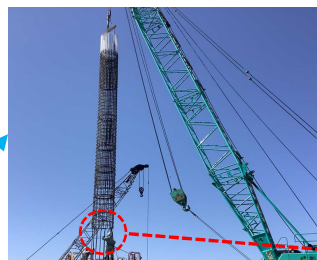
写真-3 鉄筋籠建込
