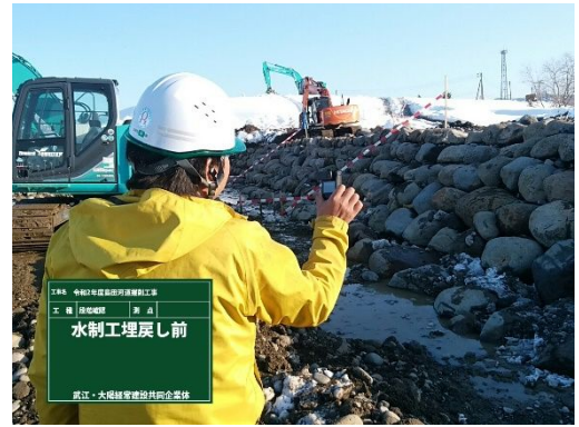
写真1 水制工不可視部分確認
