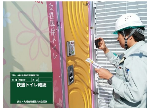
写真3 快適トイレの確認
