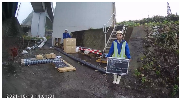
写真-9 材料確認状況
