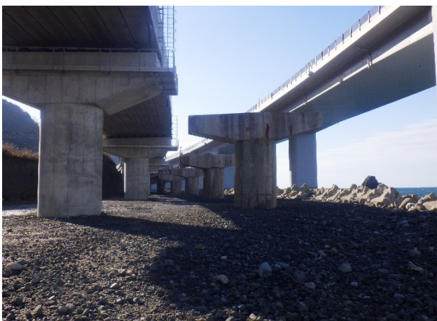
写真-3 下部工撤去部
