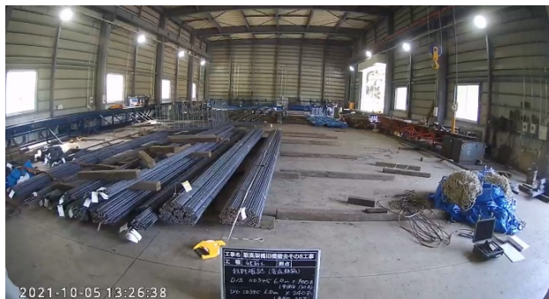
写真-8 材料確認状況
